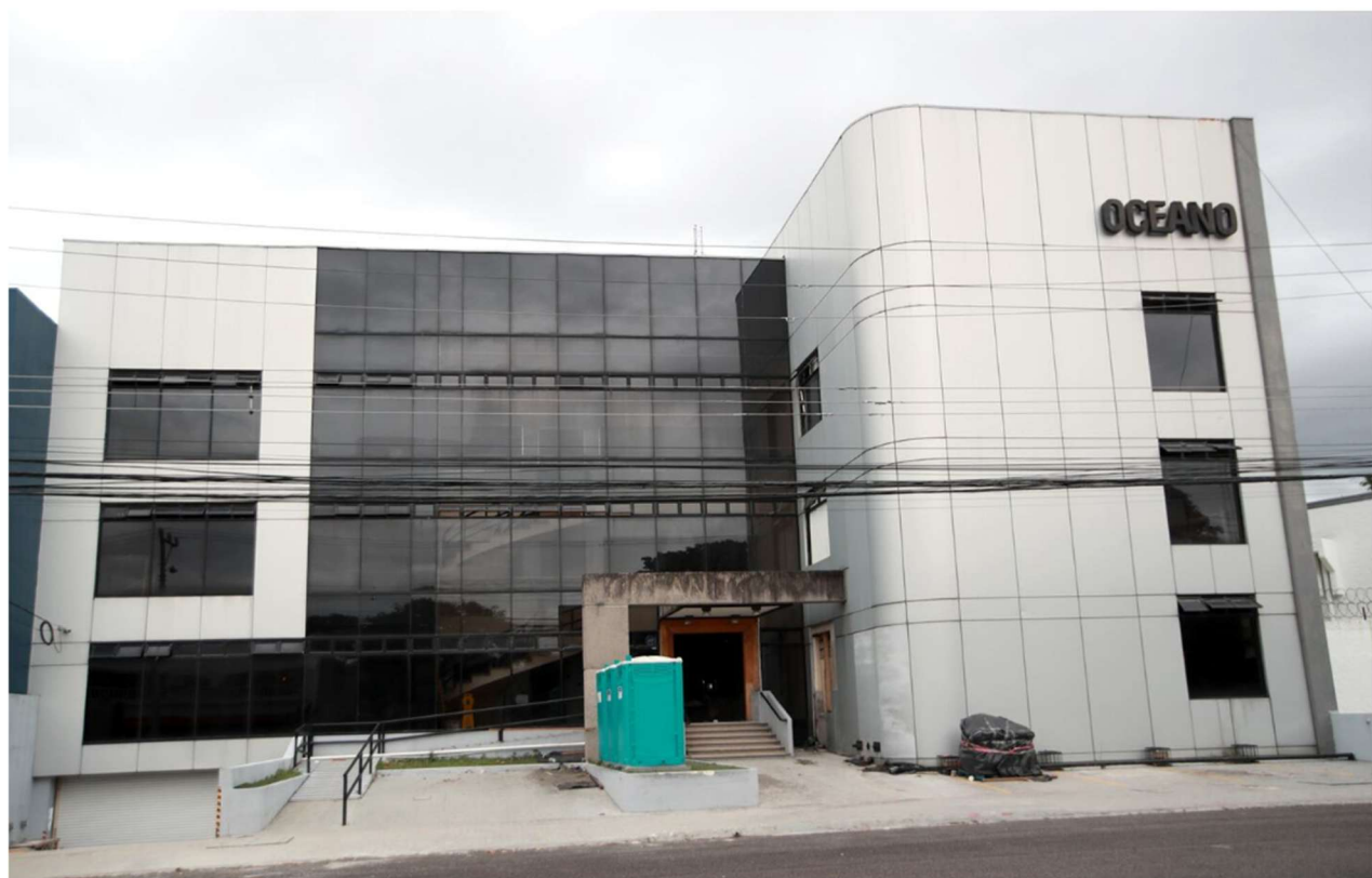
Foto 18 Edificio Océano CCSS- 1560 m2
